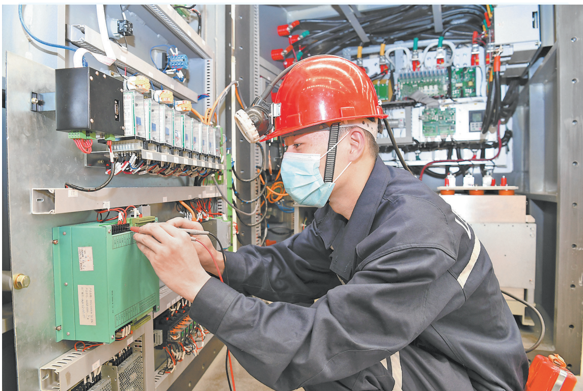
近年来，霍州煤电集团着力构建高技能人才培养体系，以“精准育才”为目标，通过组织开展技术攻关、技能培训、管理创新、科学研究、学习交流等活动，打造高素质人才队伍，为企业高质量发展提供了人才支撑。图为该企业职工正在检修高压变频器。
